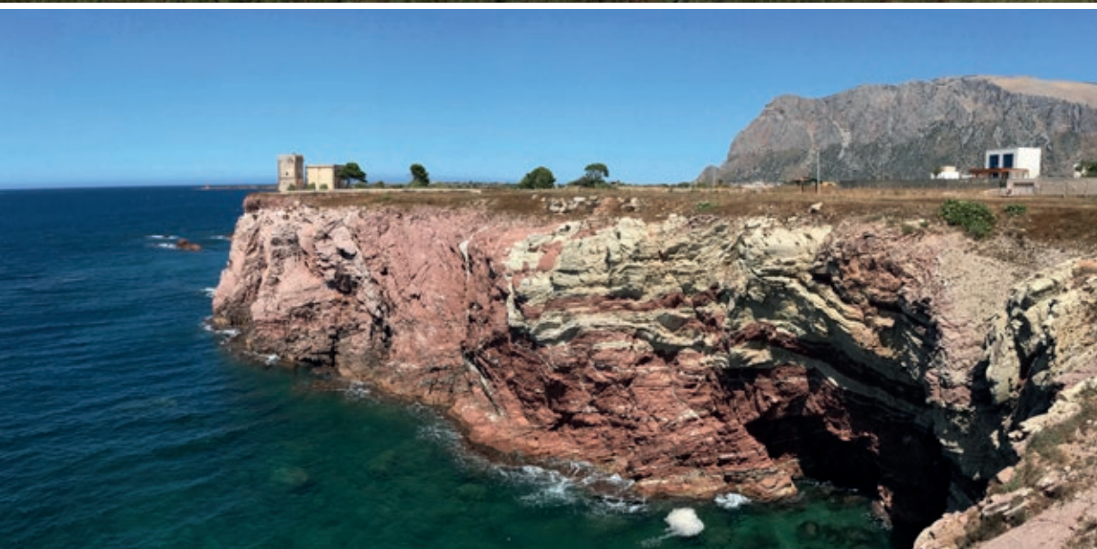
L'ESTERNO DELLA CASA E IL CONFRONTO CON L'ANTICA TORRE D'AVVISTAMENTO. A SINISTRA, IL PROSPETTO PRINCIPALE CON LE QUATTRO GRANDI APERTURE
